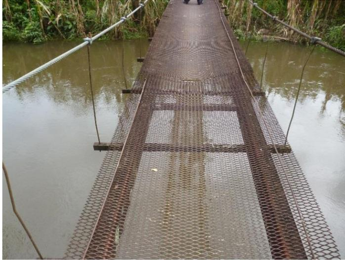
Como se puede observar en la foto. Lo que le falta al tablero es un emplantillado más acorde a su estructura metálica y aumentar la cantidad de los tensores verticales que sostiene el piso o tablero.
