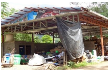
Fotografía 2, fuente propia, infraestructura del sitio de recuperación del material valorizable, dentro de las instalaciones del Relleno Sanitario de Garabito.....
