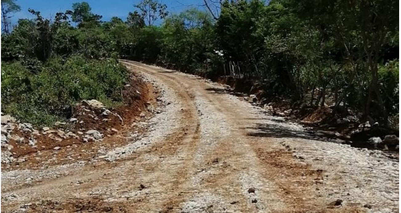
Evidencia Fotográfica Colocación de Bases y Tratamiento
